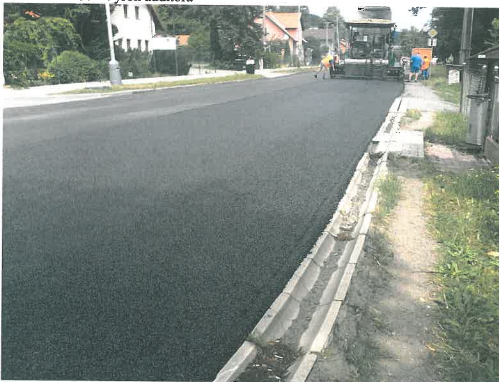
Pokládka asfaltové směsi AK 8 SH
